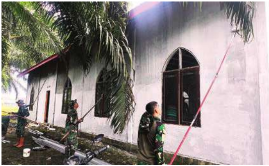
SIGAP: Tim Satgas TMMD Kodim 1011/Klk mengecat Gereja GKE Karawai di Desa Lamunti Permai, Kecamatan Mantangai.
